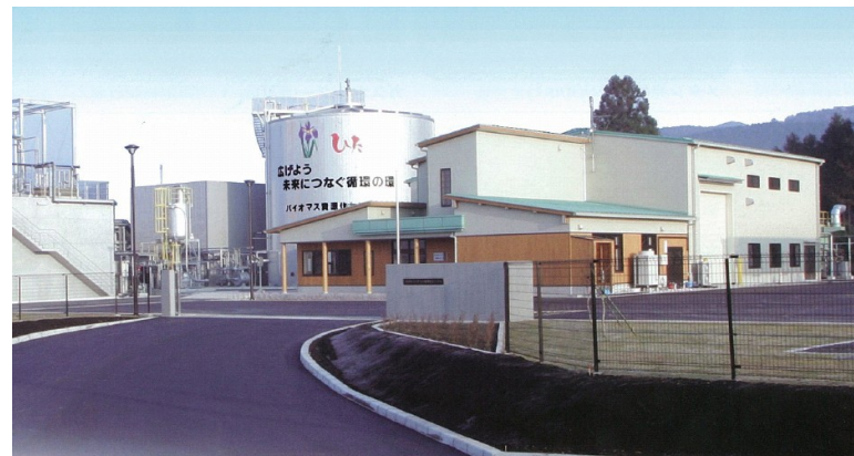
日田市バイオマス資源化センター
